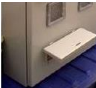
Figura 27: Portezuelas Breakers de Protección de Acometidas
