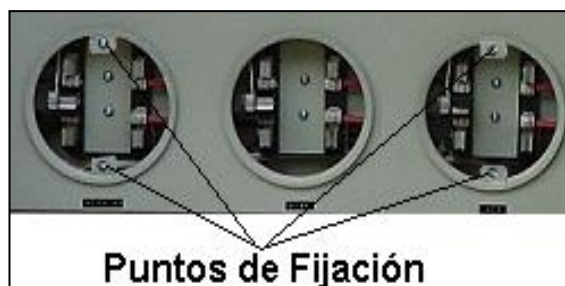
Figura 18: Fijación Laminas Cubre Falta
